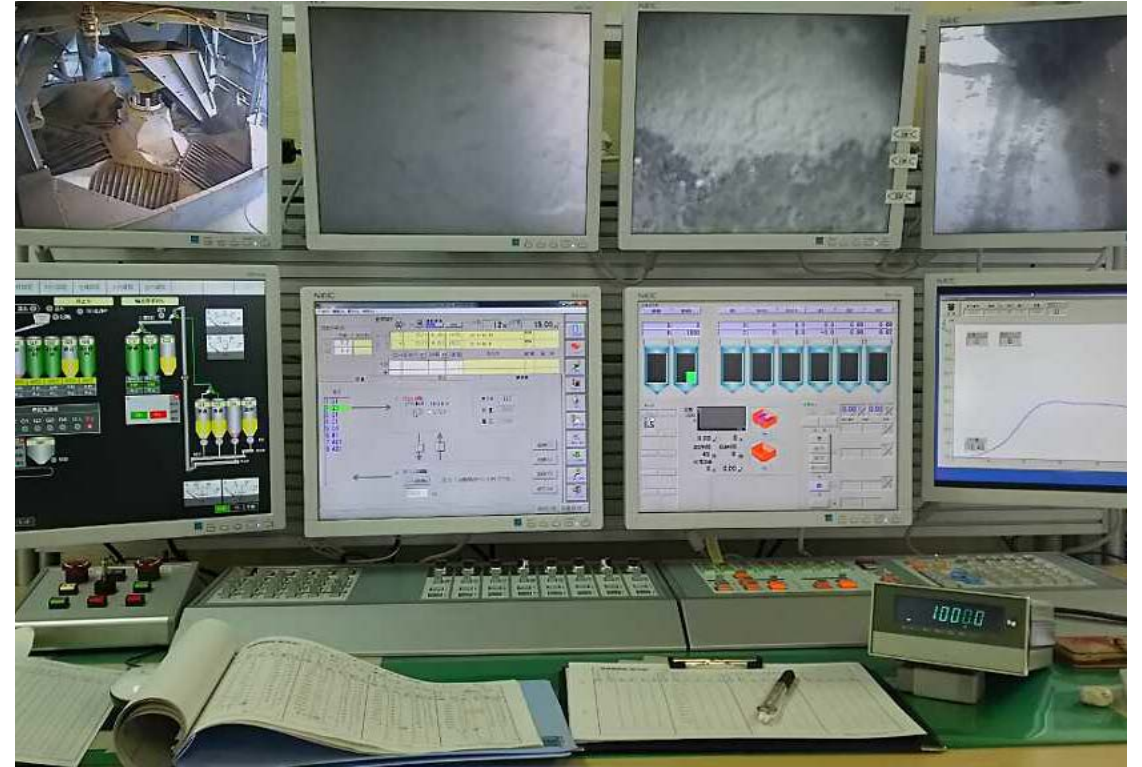
検査時操作室風景
